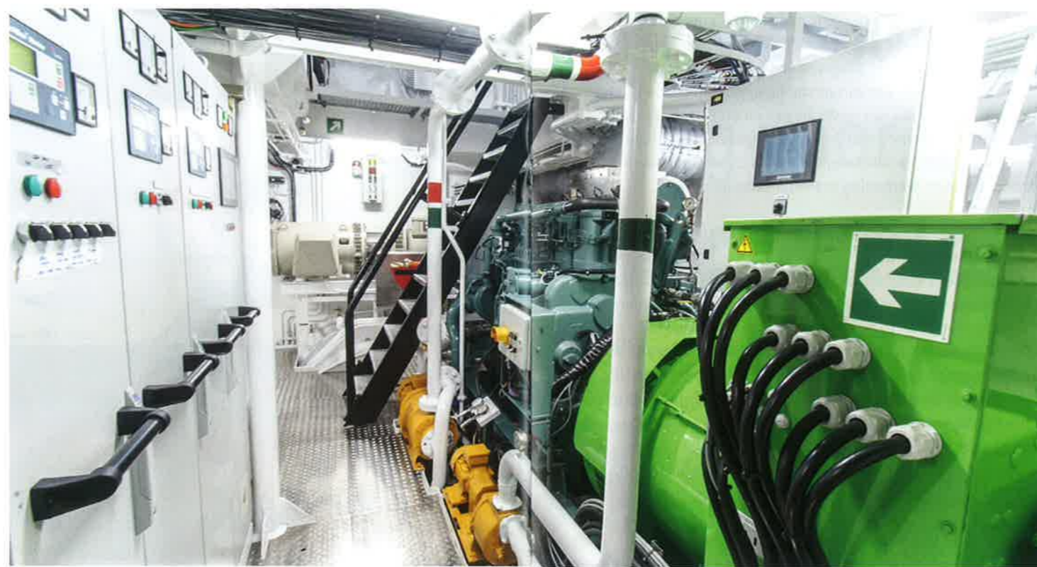
500 kW-hoofdset met variabele-speed-generator (foto Stichting MDV).
